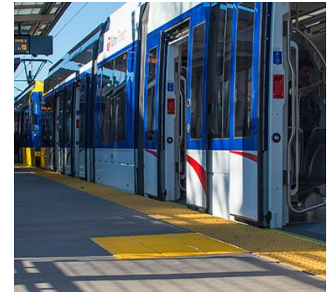
Tactile door indicator mat
